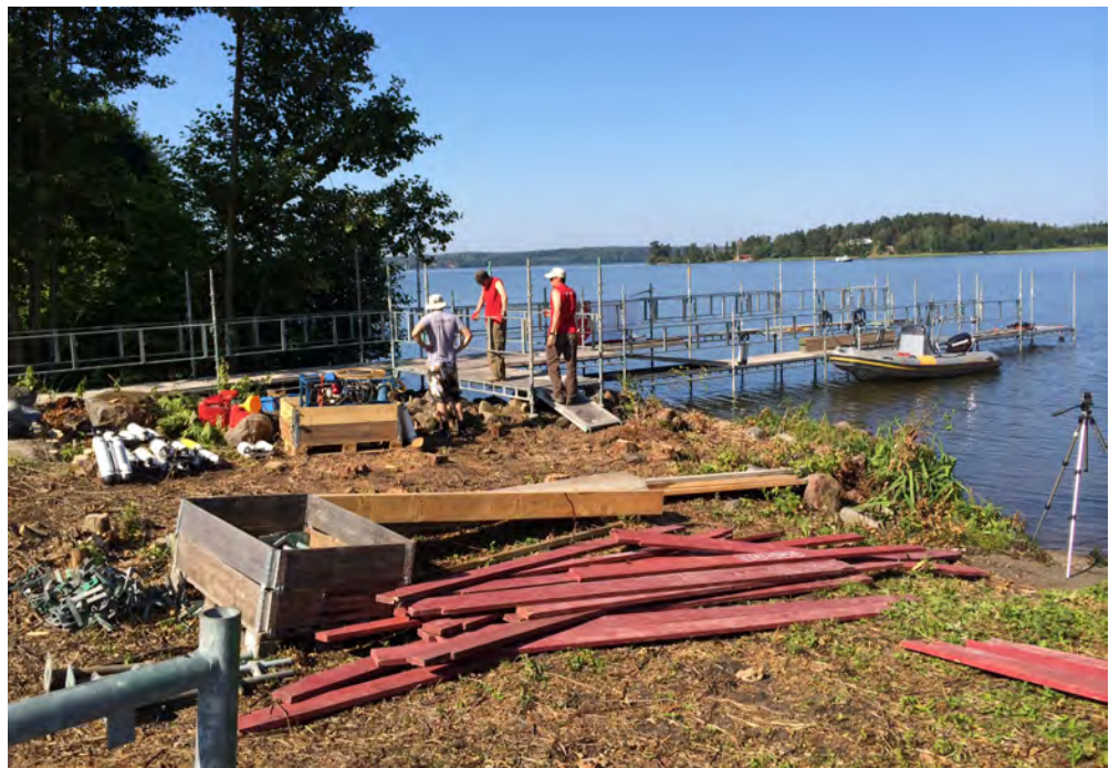
Figur 249. Arbetsplattformen 2014 byggs upp Foto: Andreas Olsson, Statens maritima museer.
